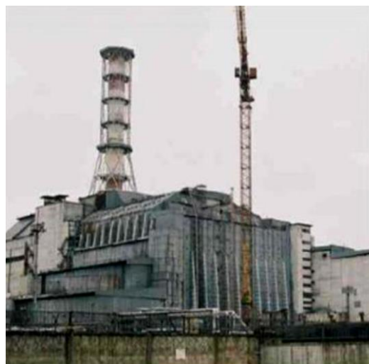
Εικόνα 3: Ο κατεστραμμένος αντιδραστήρας 4 του πυρηνικού εργοστασίου Τσερνομπίλ (αριστερά) και η «σαρκοφάγος» που χτίστηκε για την επικάλυψη του και αποφυγή των διαρροών ραδιενέργειας (δεξιά).
